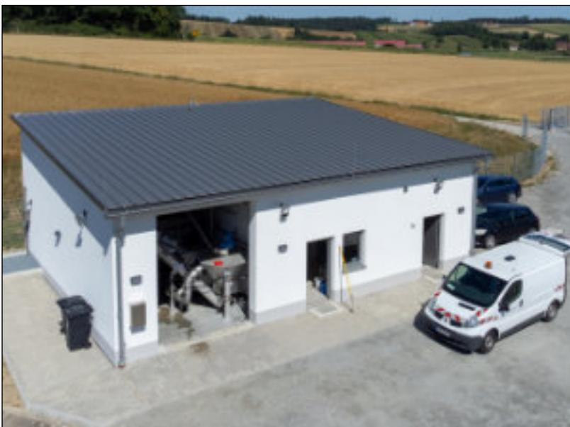
Das neue Betriebsgebäude der Kläranlage beherbergt die Technik, die Steuerung und das Labor. Von hier aus kann direkt am PC die ganze Anlage und das gesamte Kanalnetz der Gemeinde überwacht werden.
