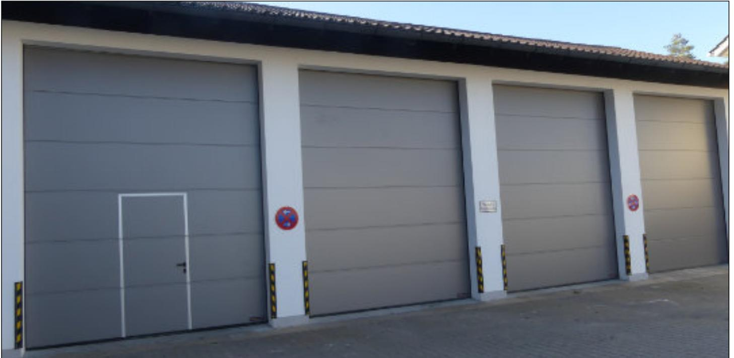
Im zweiten Bauabschnitt wurden dann die östlichen Bauhofhallen saniert. Alle Hallenabschnitte erhielten neue Sektionaltore, zum Teil mit integrierter Tür.
